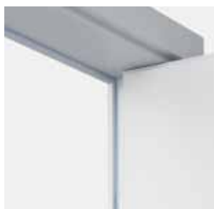
Roh zárubně z vnitřní strany
