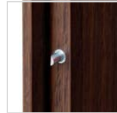
3 ZAJIŠŤOVACÍ ČEPY PROTI VYSAZENÍ DVEŘÍ
