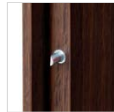
4 ZAJIŠŤOVACÍ ČEPY PROTI VYSAZENÍ DVEŘÍ
